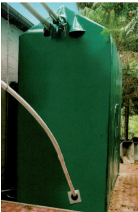
UV-Silo, mit Abdeckung wetterfest verpackt
