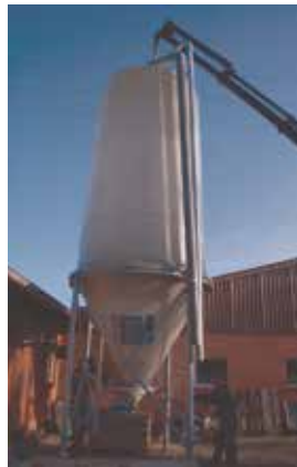
3 x 30 m 3 Silos für Masthähnchenstall
