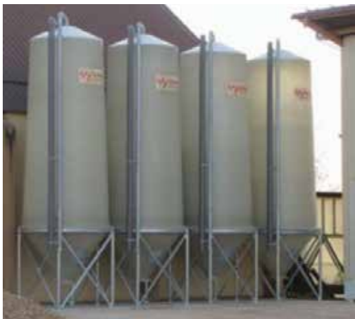
4 x 25 m 3 Silos für Saatgut
