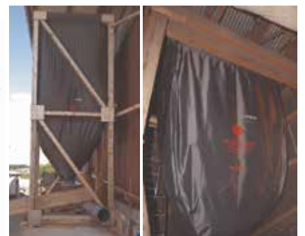
Tragrahmen eingebaut
