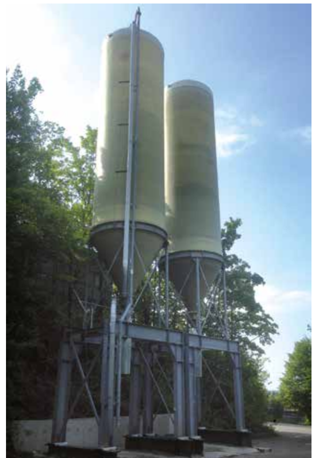
Einfache und sehr schnelle Montage der Standardsilos durch umfangreiche Vormontage
