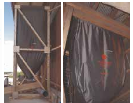
Tragrahmen eingebaut
