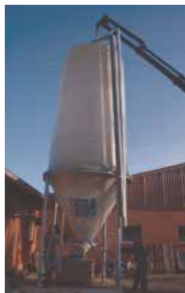
3 x 30 m 3 Silos für Masthähnchenstall
